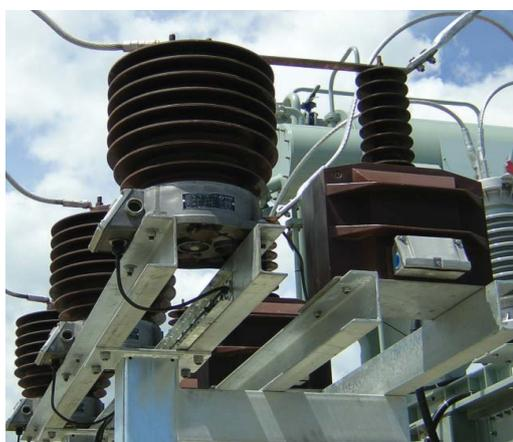
▶ Transformadores de intensidad (CR) y tensión (UR) de 36 kV. Medida para facturación. Electronet Services (Nueva Zelanda).
